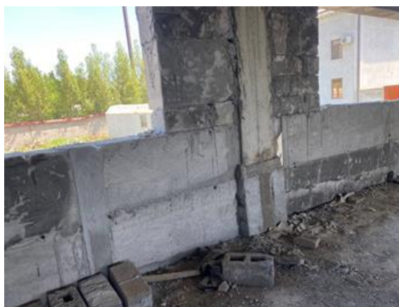
1-расм. Бино ташқи тўсиқ конструкцияларини кўпикбетондан конструкция жойида қуйма усулда барпо этиш жараёни.
