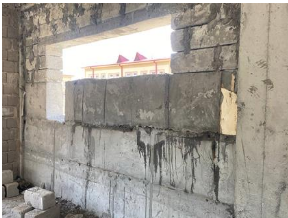
1-расм. Бино ташқи тўсиқ конструкцияларини кўпикбетондан конструкция жойида қуйма усулда барпо этиш жараёни.
