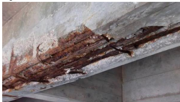
1-расм. Тўсин ҳимоя қатламининг кўчиб бузилиши
